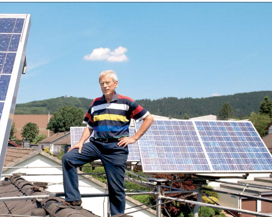
Schweims und seine nachgeführte Anlage. Sie erhöht die »Ernte« noch einmal um 30 Prozent.
