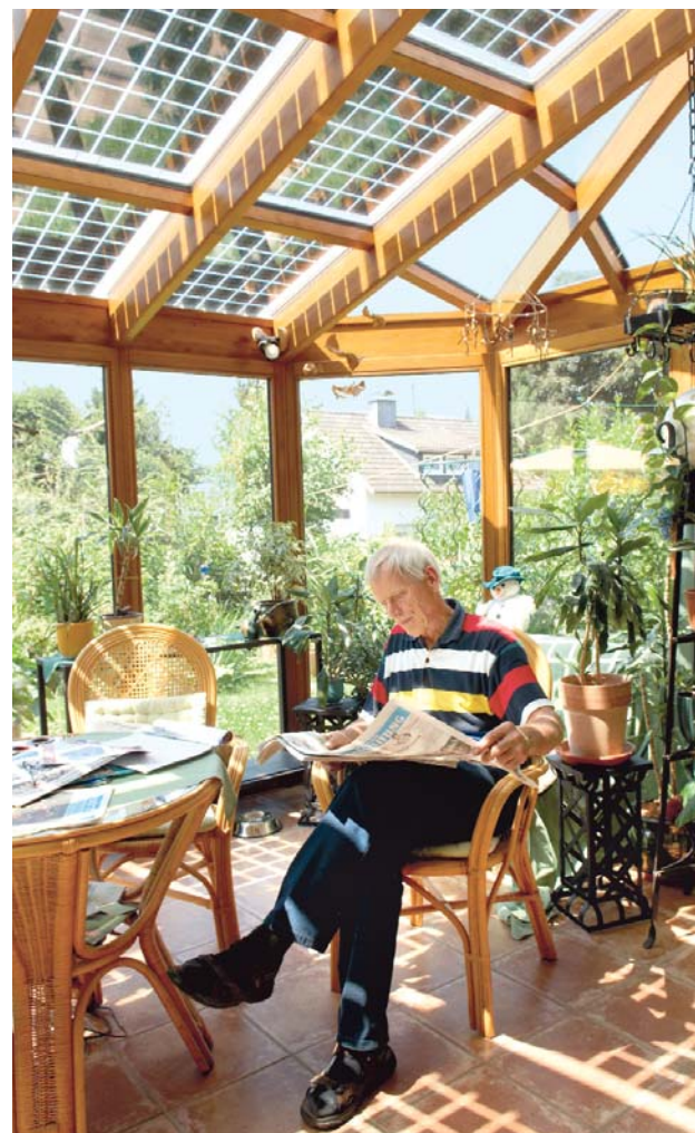
Die Photovoltaik-Zellen im Wintergartendach ersparen einen Sonnenschutz.
