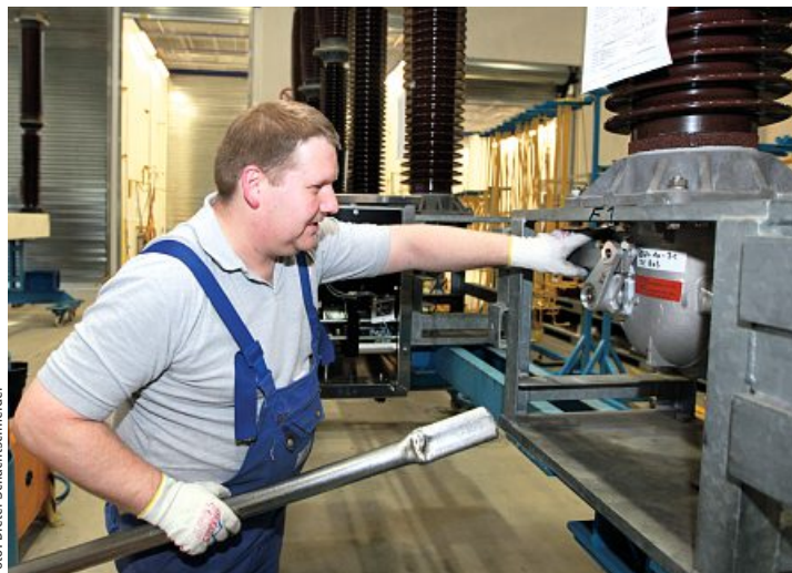
Frank Figge am Prüffeld für Schaltanlagen: Der Arbeitsplatz des 43-jährigen ist dank des Einsatzes von Betriebsrat und IG Metall für drei Jahre sicher.
