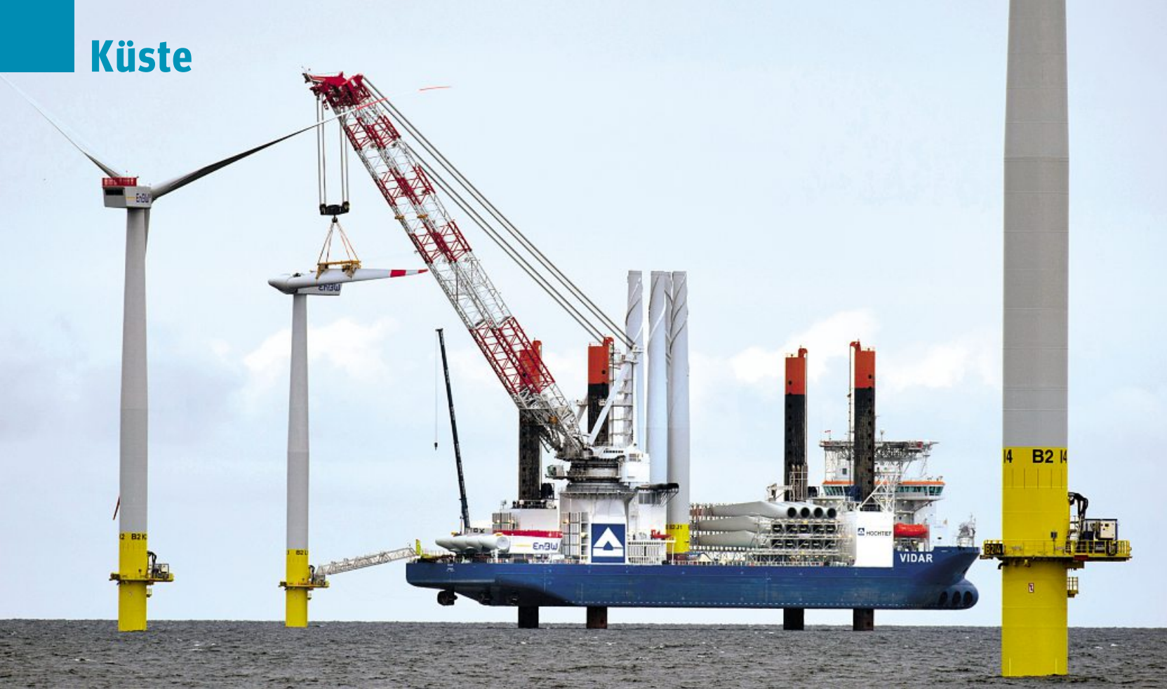
Eines der wenigen Projekte in der Ostsee? Bau des Offshore-Windparks Baltic II vor der Küste in Mecklenburg-Vorpommern
