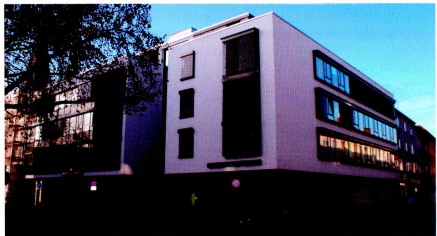
Gewerkschaftshaus in Braunschweig
