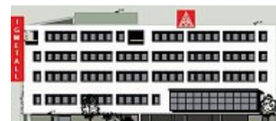
Neubau in der Bergstraße
