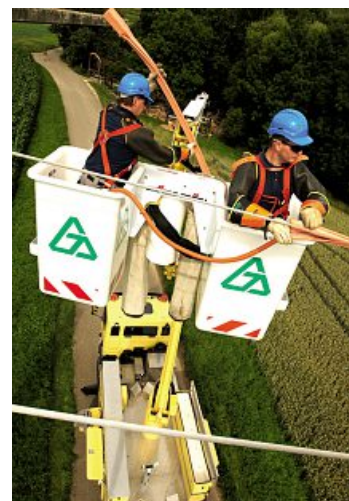
Mehr Geld für die Monteure der GA Hochspannung Leitungsbau GmbH
