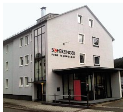
ERA wurde bei Scherzinger umgesetzt.
