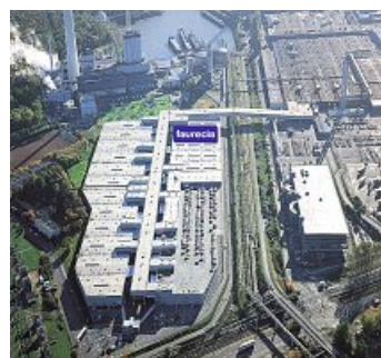
Luftaufnahme des gesamten Supplierparks mit Kennzeichnung des Betriebes Faurecia
