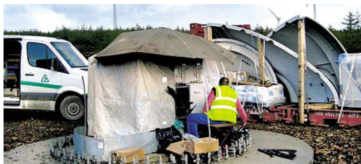
Unser Bild zeigt eine GA Energieanlagen Nord-Baustelle.
