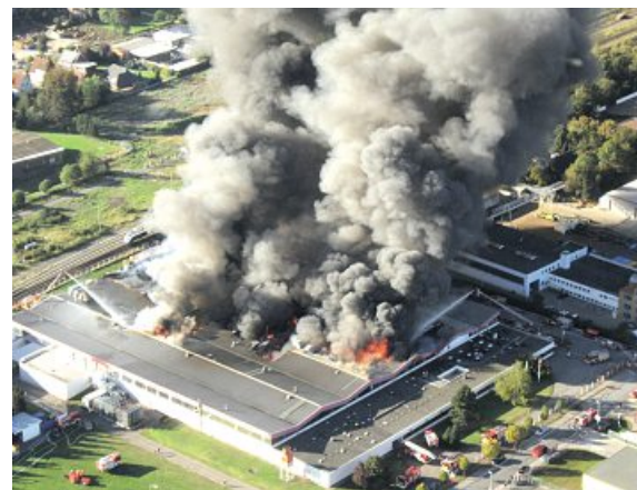
Großbrand bei der Firma Lear in Quakenbrück.
