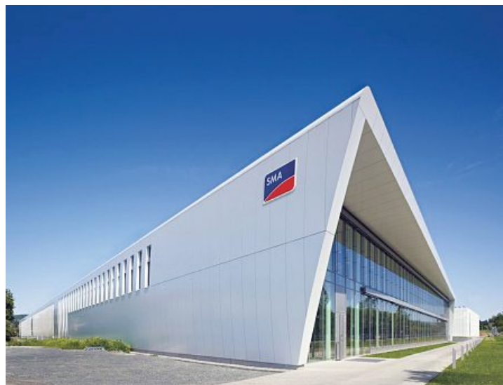
Das futuristisch wirkende neue Solar-Werk 1 arbeitet CO 2 -neutral. Leserinnen und Leser der metallzeitung können sie nun besichtigen.
