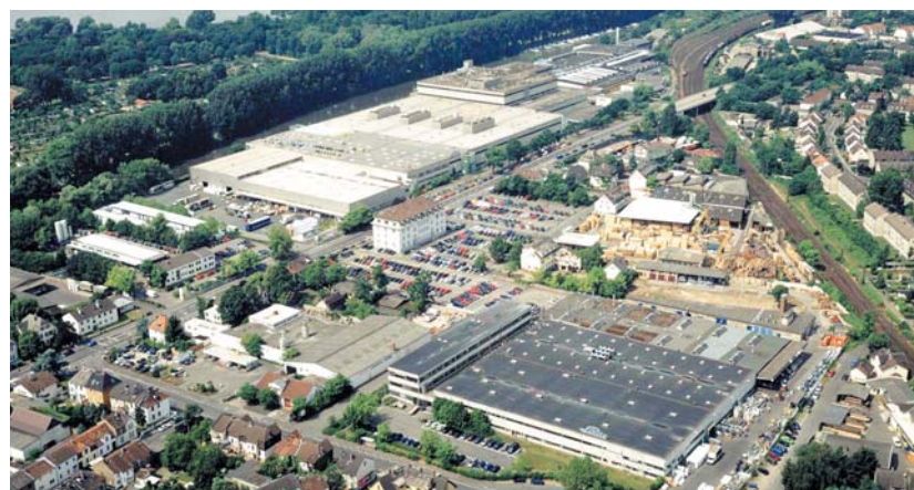
Die Produktionsstätten von Linde Kältetechnik in Kostheim. Werk 1 (oben) ist »plattgemacht«. Wie lange geht es im »weißen Haus« (Mitte) und im Werk 2 (unten) mit 235 Beschäftigten weiter?
