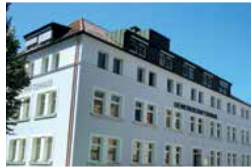
Abbildung 15: Das neue Gewerkschaftshaus Landshut befindet sich in der Nikolastraße 49, circa einen Kilometer vom Stadtzentrum entfernt.
