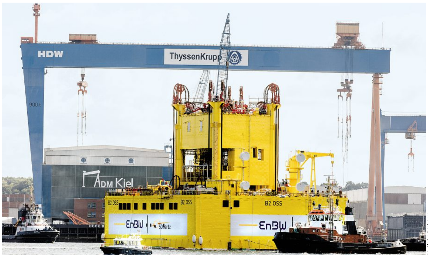
Einer der zu wenigen Offshore-Aufträge: Schlepper ziehen bei ADM in Kiel eine Umspannstation für den Windpark Baltic 2 auf die Ostsee.
