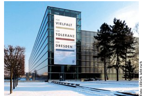
An der Automobilmanufaktur Dresden wurde ein weithin sichtbares Zeichen gesetzt.
