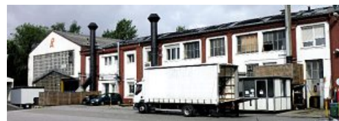
Anke-Betriebsgebäude auf der Rellinghauser Straße
