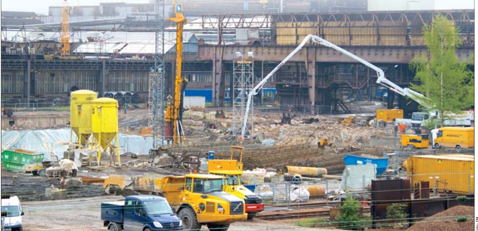
Die riesige Baugrube der Großbaustelle für die modernste Freiformschmiede in Völklingen ist schon ausgehoben.
