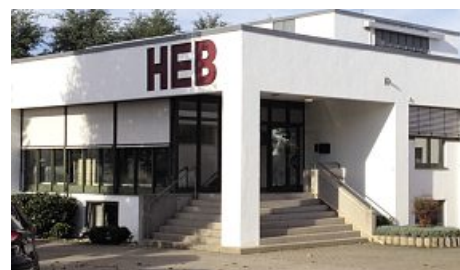
HEB Hydraulik-Elementebau in Freiburg-Hochdorf
