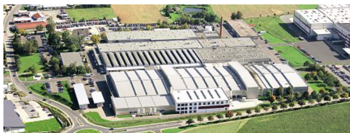
Luftbild Siemens Kemnath
