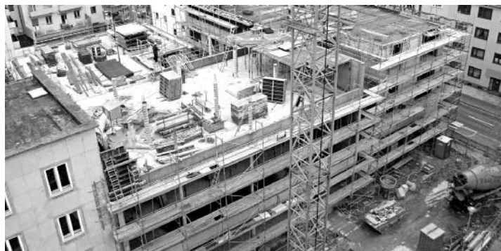
Das neue Gewerkschaftshaus und Kommunikationszentrum in Braunschweig nimmt Gestalt an
